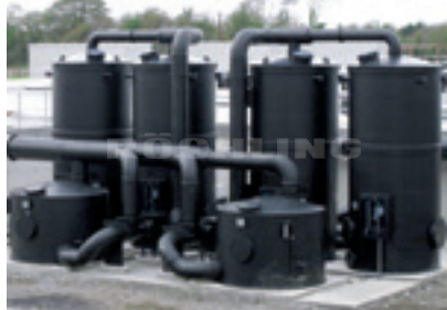
Polystone® G noir B 100 Système de dépollution de l'air dans une usine de traitement des eaux
