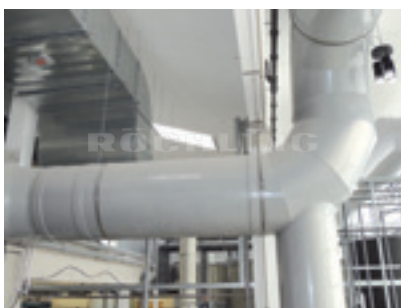
Polystone® PPs gris Système de ventilation
