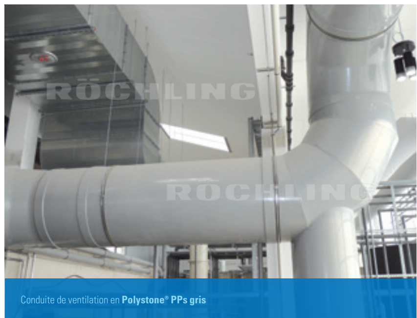
Polystone® P Homopolymère gris Système de ventilation pour une ligne de galvanisation
