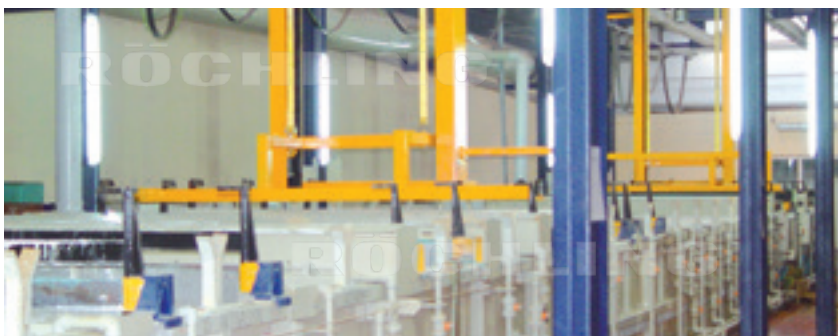
Polystone® P Homopolymère gris Ligne de galvanisation pour le traitement de pièces en aluminium
